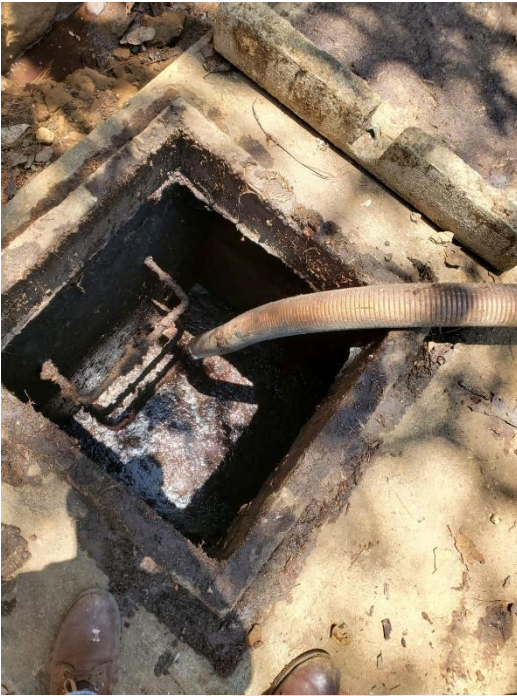
Limpieza de fosa del rastro municipal
