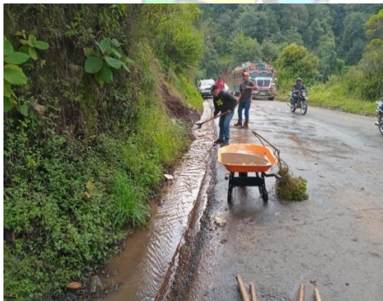
Limpieza de cunetas por derrumbes en el lugar denominado La Pedrera
