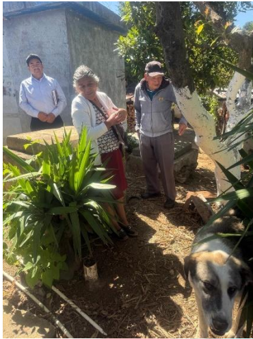
En tanque de captación de Agua, cabecera municipal
