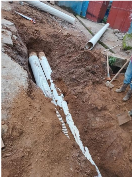
Reparación del tubo principal de conducción de Agua potable de la cabecera municipal.
