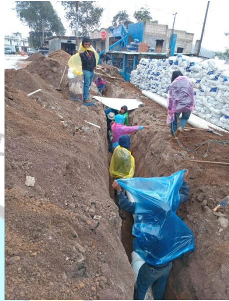
Reparación del tubo principal de conducción de Agua potable de la cabecera municipal.
