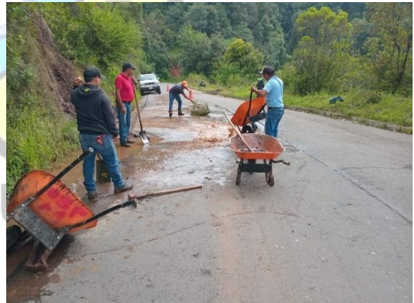
Limpieza de cunetas por derrumbes en el lugar denominado La Pedrera
